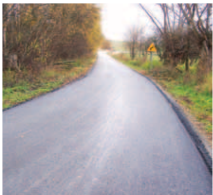
Odbudowa drogi gminnej nr 107294L od km 1+105 do km 2+100 w miejscowości Antoniówka (995 m)
