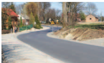
Trakt komunikacyjny Kosarzew – Teklin – Bychawa zrealizowany z „Programu rozwoju gminnej i powiatowej infrastruktury drogowej na lata 2016–2019” w ramach zadania „Przebudowa ciągu komunikacyjnego obejmującego drogi powiatowe nr 2287L i 2300L poprawiająca bezpieczeństwo ruchu drogowego na terenie gm. Bychawa i gm. Krzczonów”. Długość ciągu to 10,5 km, z tego w naszej gminie to ponad 7 km.
