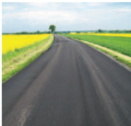
Przebudowa drogi powiatowej nr 2272L Krzczonów – Sobieska Wola (7,403 km)
