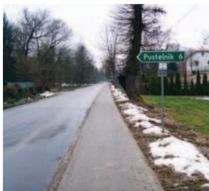
Wykonanie chodnika w miejscowości Krzczonów, ul. Leśna (0,337 km)
