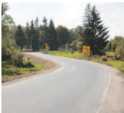
„Przebudowa nawierzchni drogi powiatowej 2129L Gielczew – Sobieska Wola – Dąbie na odcinku Sobieska Wola – Dąbie oraz 2302L Krzczonów I – Krzczonów II – Sobieska Wola na odcinku Krzczonów I – Krzczonów II”.
