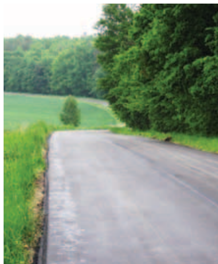
Odbudowa drogi powiatowej nr 2125L od km 0+000 do km 6+625 w m. Walentynów, Pamięcin i Pustelnik (6,625 km)
