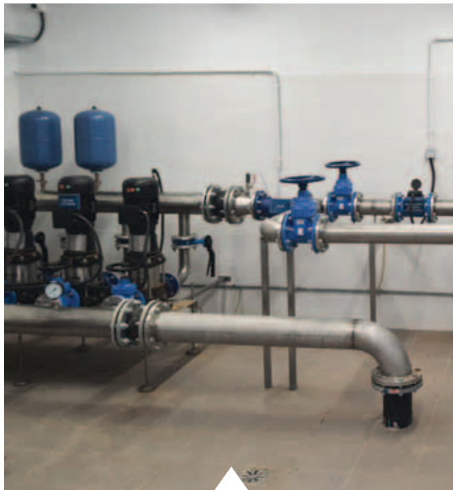
Budowa, przebudowa (modernizacja) wodociągu w miejscowości Krzczonów Wartość ogółem: 5 680 124,53 zł Dotacja: 2 951 000,21 zł Długość odcinka: 19,5 km
