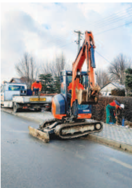
Budowa energooszczędnego oświetlenia
