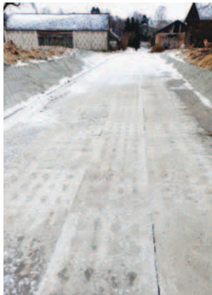
Utwardzenie i odwodnienie wężowu lessowego w Olszance
