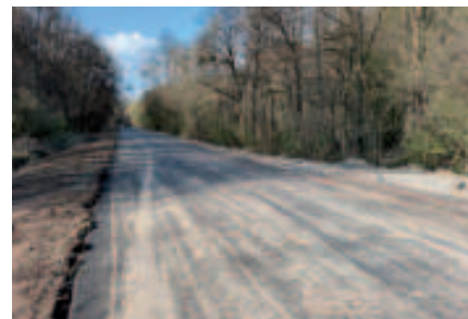
Przebudowa drogi w Żukowie
